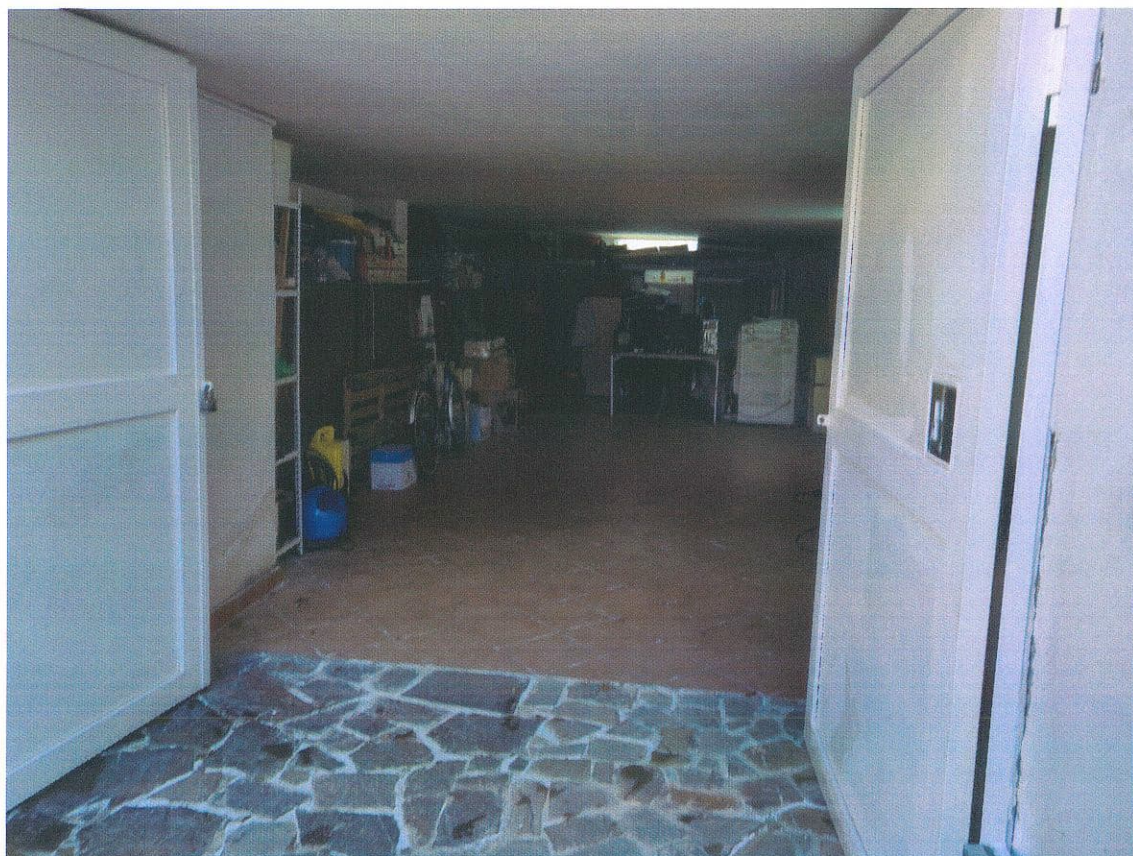
Foto 16 – Deposito al piano seminterrato
